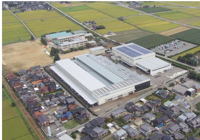
KIF 外観(キタムラ機械 本社工場)
